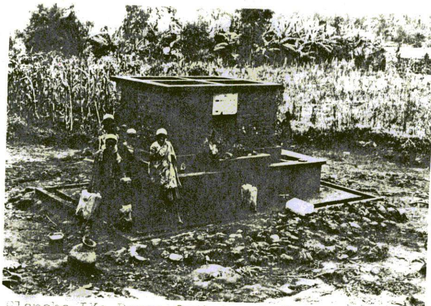
Planche IX: Borne-fontaine de Rutamba. Un robinet est mis hors d'usage. L'autre fonctionne mal. Remarquer aussi l'importance des éléments féminins et de l'utilisation du "jerrycan" comme récipient employé.
